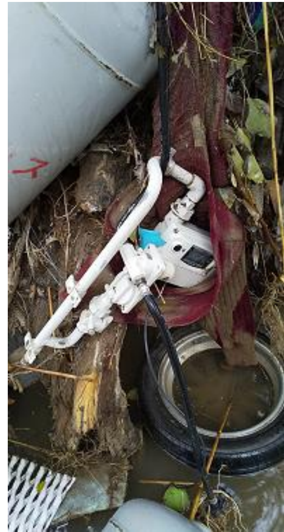
濁流により引きちぎられたガス放出防止型高圧ホース 防止機能が働いてガス漏れはなし
