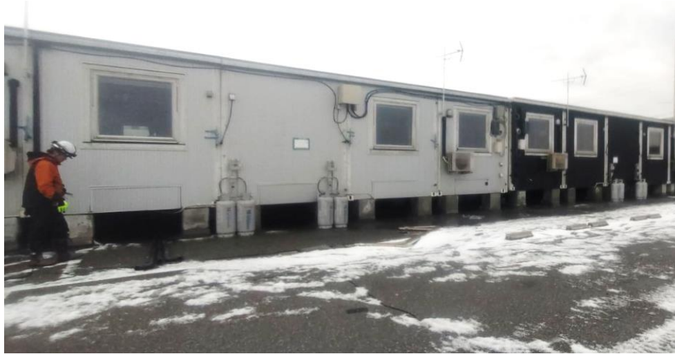
輪島市マリンタウン仮設住宅
