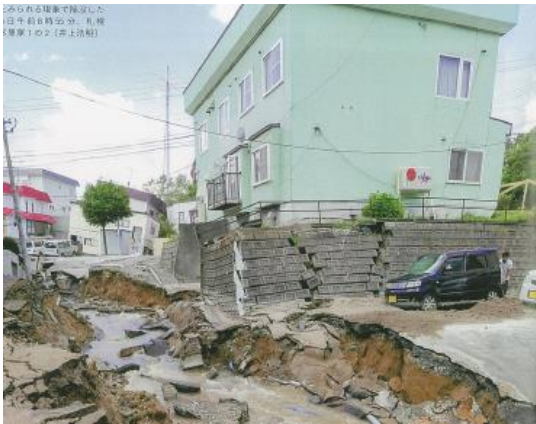
山肌はいたるところで崩れ、地盤沈下でマンホールも浮き上がっている。
