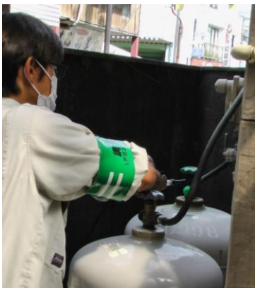
緊急点検でバルブを閉
