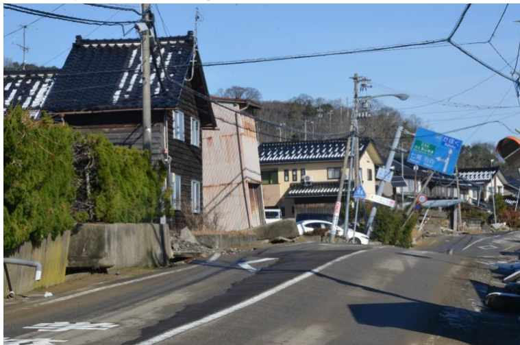
内灘町河北潟の沈下してゆがむ道路
