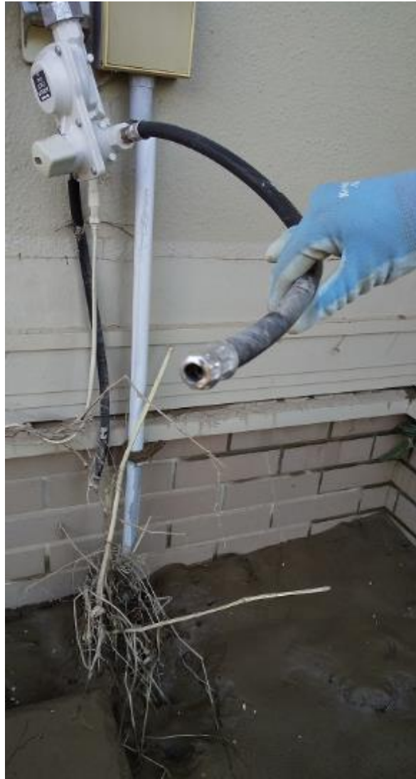
濁流により引きちぎられたガス放出防止型高圧ホース 防止機能が働いてガス漏れはなし
