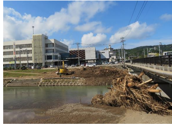
流木が堆積した河原田川
