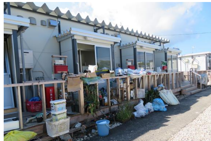
浸水した宅田町仮設住宅
