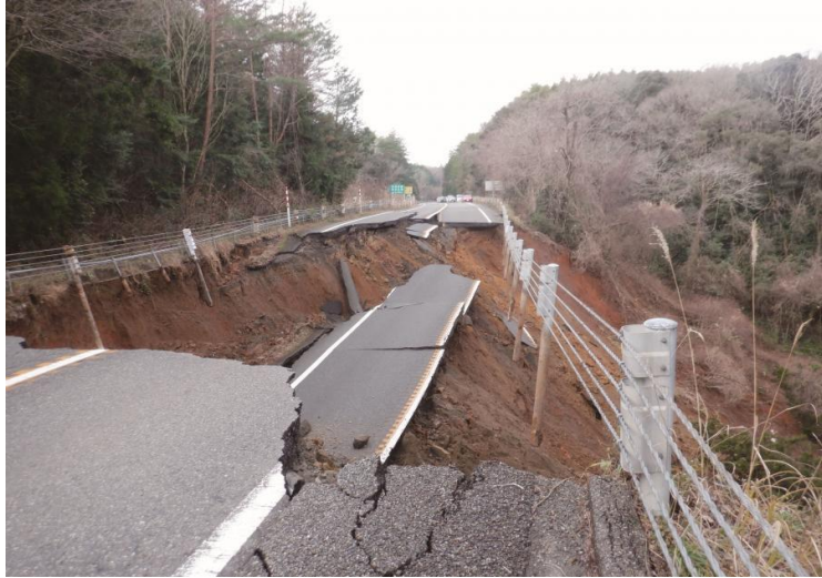
内灘町河北潟の沈下してゆがむ道路
