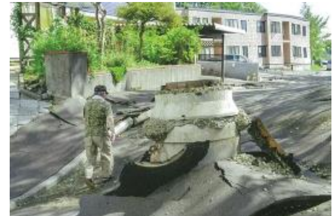
山肌はいたるところで崩れ、地盤沈下でマンホールも浮き上がっている。
