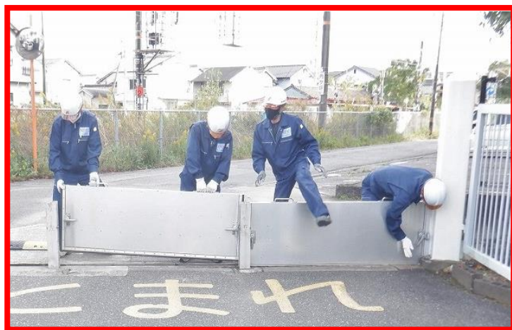
浸水防止版の設置
