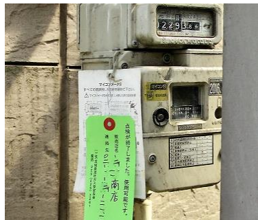
水没した機器には使用の可否を明確にする。
