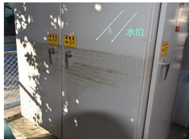
発電機 嵩上げ工事
